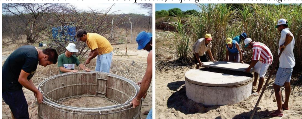
FIGURA 1. Construção e poço amazonas construído em pré-moldados. Fonte: ASA Pernambuco (2017).
