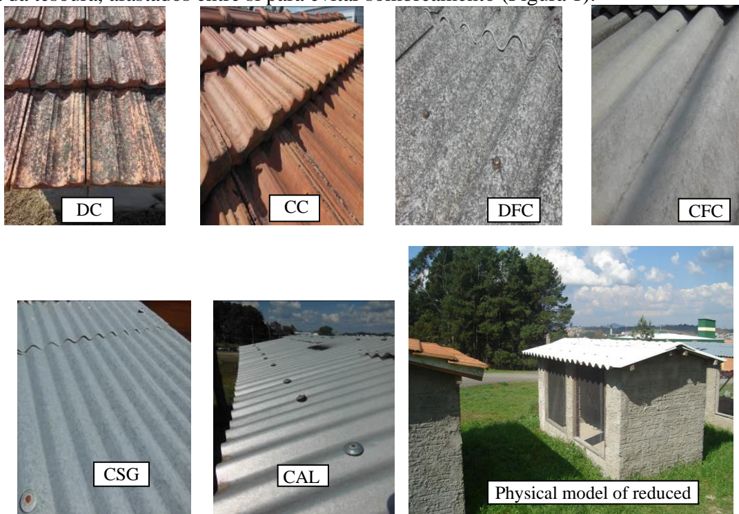
Figura 1. Vista externa das coberturas e modelo em escala reduzida de instalações rurais. Os 6 telhados avaliados, considerados tratamentos, foram: telhado sujo (DC) e limpo (CC) de telhas de barro cerâmico tipo francesa (20mm de espessura; k \cong 0,93 \text{ W/mK} ; \varepsilon = 0,95 ). Telhado sujo (DFC) e limpo (CFC) de telhas de fibrocimento corrugado (5mm de espessura; k \cong 0,65 \text{ W/mK} ; \varepsilon = 0,95 ). Telhado limpo de aço galvanizado corrugado (CSG) (0,5mm de espessura; k \cong 50,2 \text{ W/mK} ; \varepsilon = 0,25 ). Telhado limpo de aluzinco corrugado (CAL) (0,5mm de espessura; k \cong 205 \text{ W/mK} ; \varepsilon = 0,04 ). k , \varepsilon representam condutividade térmica e emissividade, respectivamente. Telhas sujas significam presença de musgo, líquen e poeira, enquanto telhas limpas significam ausência de musgo, líquen e poeira. As aberturas, principalmente no telhado, foram fechadas com espuma de poliuretano para evitar ao máximo, trocas térmicas pelo vento. O entorno era formado por grama rala e cascalho e as laterais norte-sul foram
