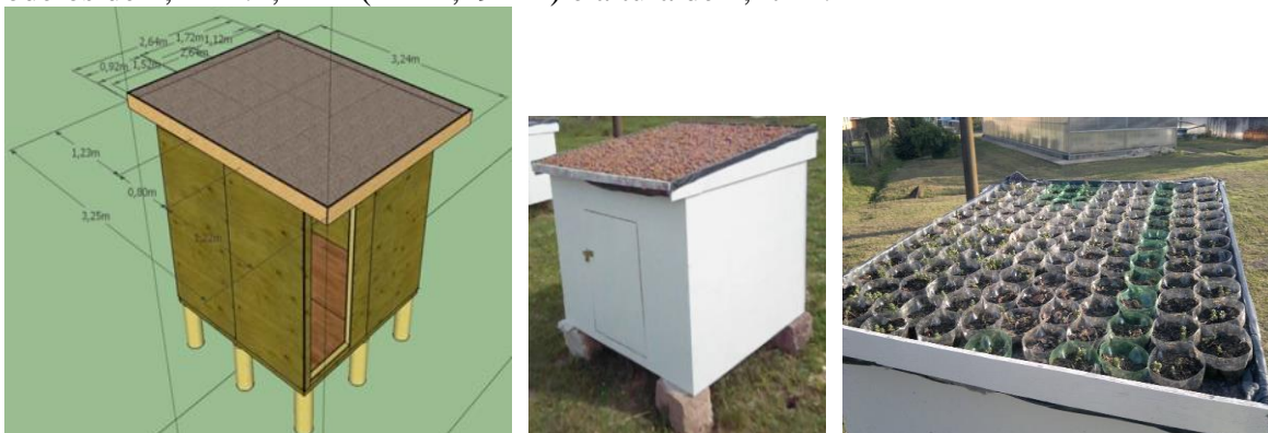
Figura 1. Vista da construção em wood frame (1:1) com a estrutura das coberturas.
