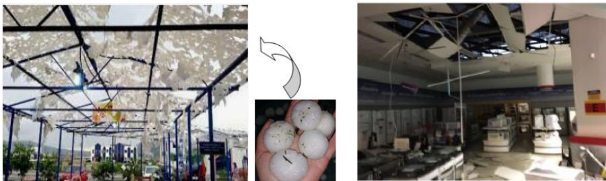
Figura 2. Coberturas danificadas por chuva de granizo ocorrida em Lages/SC em 13/10/2014 e em 10/11/2017.
