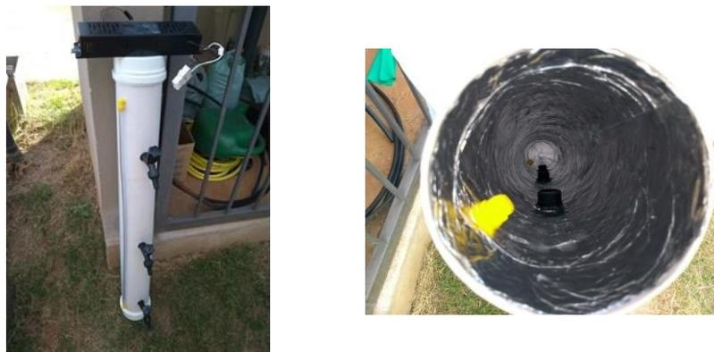
FIGURA 1. Sistema de desinfecção UV instalado na ETE/UFLA.
