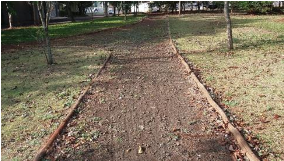
FIGURA 3: Foto da estrutura de bioengenharia de solo e elementos construtivos
