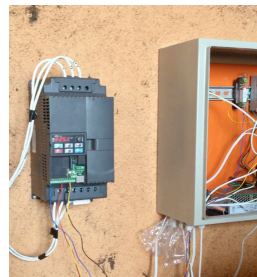
FIGURA 2. Instalação do Inversor de Frequência.
