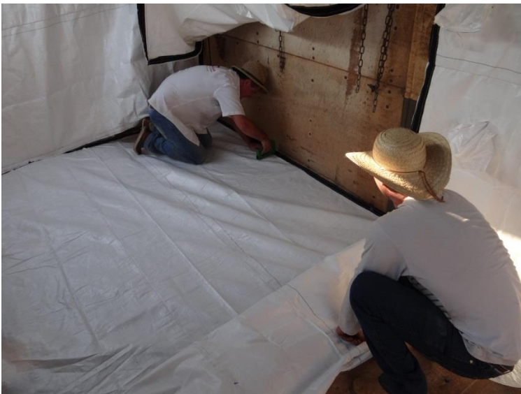
Figura 4 - Início da fixação no assoalho.
