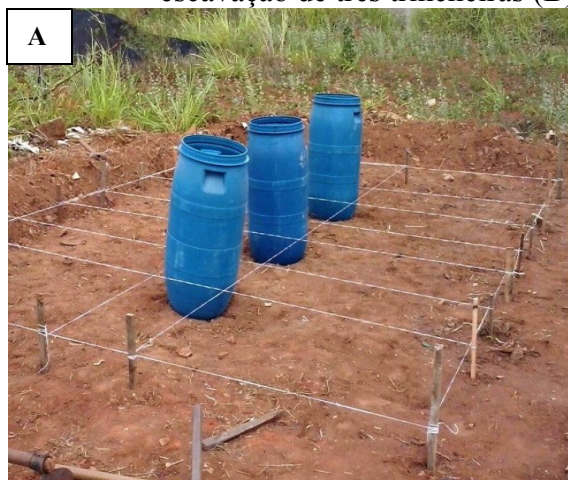
Figura 1. Marcação da área de instalação dos lisímetros de drenagem: piquetes (A), escavação de três trincheiras (B)
