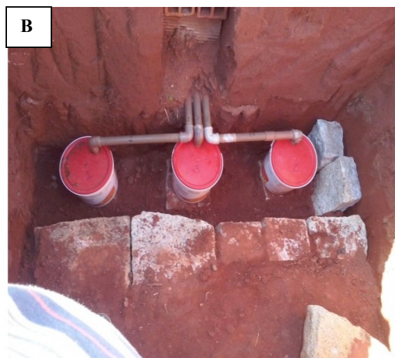
Figura 2. Instalação dos lisímetros de drenagem: colocação dos lisímetros (A), trincheira para recipientes coletores (B)
