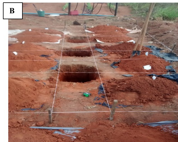
Figura 1. Marcação da área de instalação dos lisímetros de drenagem: piquetes (A), escavação de três trincheiras (B)
