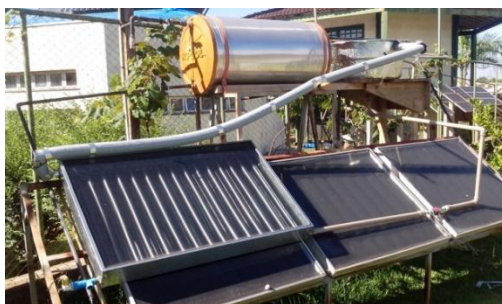
FIGURA 1 - Coletor de placa plana (FPC).
