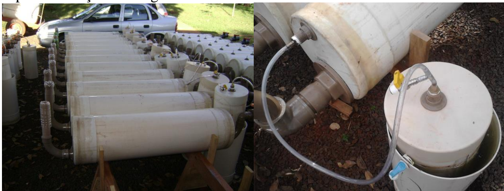
FIGURA 1. Biodigestores e gasômetros
