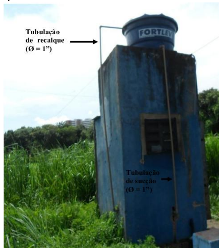
Figura 2. Reservatório elevado da unidade de bombeamento Fonte: Feitosa, 2014.
