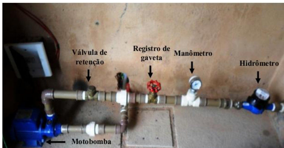
Figura 3. Componentes do sistema hidráulico de bombeamento Fonte: Feitosa, 2014.
