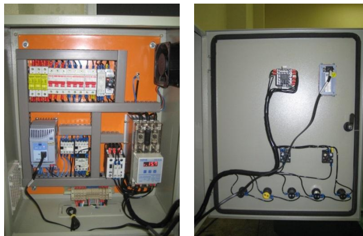
Figura 6. Vista interna (à esquerda) e da tampa (à direita) do painel de controle de temperatura e fluxo de ar de secagem.
