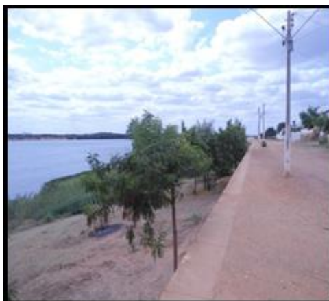
Figura 2: Orla fluvial do Município de Curaçá – BA com inclinação que interceptam águas pluviais para o Rio São Francisco.
