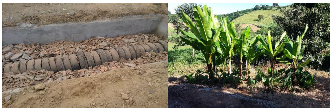
Figura 4 – TE evap em construção e vista externa do tanque em funcionamento.
