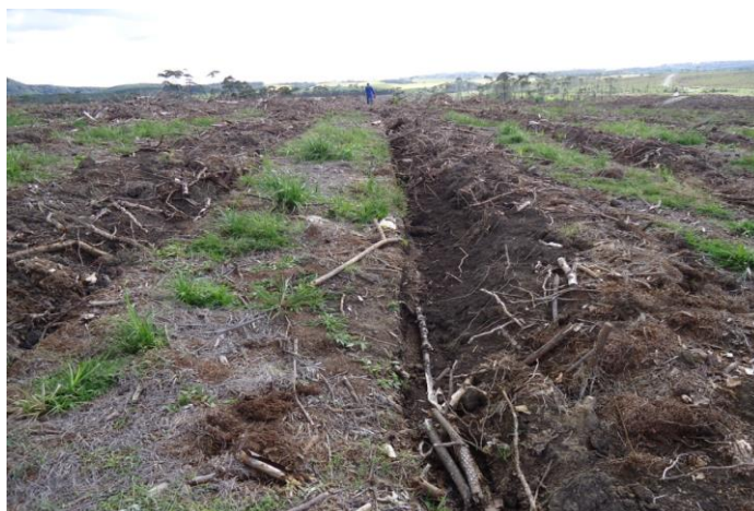
FIGURA 2. Alinhamento do preparo de solo. Fonte: JAROCZEWSKI (2014).
